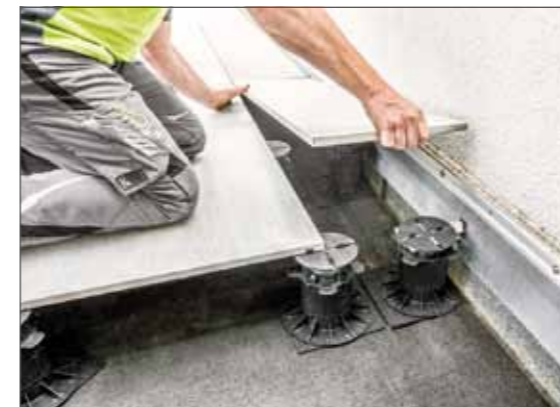
Besondere Sorgfalt war im Übergangsbereich der Terrassen zum Wohnraum im Bereich der Fenstertür erforderlich. Hier musste nach DIN18040-2 eine Entwässerungsrinne verbaut werden, um bei Starkregen oder Schneeverwehungen das Eindringen von Wasser in den Innenbereich zu verhindern.
