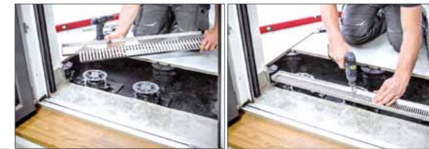
Besondere Sorgfalt war im Übergangsbereich der Terrassen zum Wohnraum im Bereich der Fenstertür erforderlich. Hier musste nach DIN18040-2 eine Entwässerungsrinne verbaut werden, um bei Starkregen oder Schneeverwehungen das Eindringen von Wasser in den Innenbereich zu verhindern.
