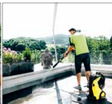
Die unansehnliche Holzterrasse wurde demontiert und die darunter liegende, unversehrte Bitumenbahn von grobem Schmutz befreit.
