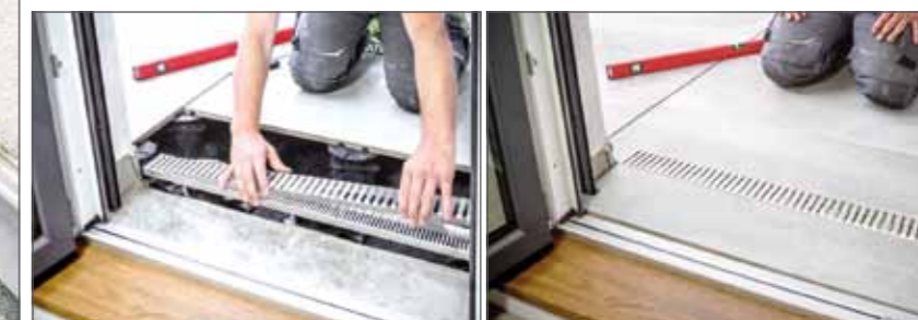
Besondere Sorgfalt war im Übergangsbereich der Terrassen zum Wohnraum im Bereich der Fenstertür erforderlich. Hier musste nach DIN18040-2 eine Entwässerungsrinne verbaut werden, um bei Starkregen oder Schneeverwehungen das Eindringen von Wasser in den Innenbereich zu verhindern.
