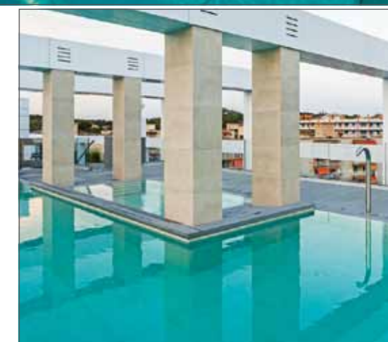
Der 85 m 2 große Pool und der 15 m 2 große Whirlpool liegen direkt nebeneinander. Im Inneren der beiden mittigen Stützen befinden sich die Ablftschächte der Hotelbäder.
