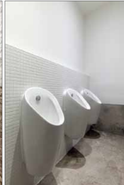
Die Spülung des WCs und der Urinale wird berührungslos ausgelöst. Blickfang über dem WC ist die schwarze, gläserne Betätigungsplatte mit den blauen LEDs.
