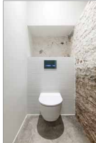
Die Spülung des WCs und der Urinale wird berührungslos ausgelöst. Blickfang über dem WC ist die schwarze, gläserne Betätigungsplatte mit den blauen LEDs.
