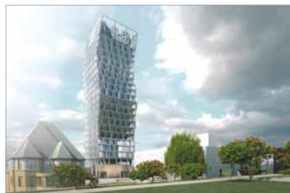
Die spektakuläre Architektur des Ardex-Towers spielt mit den Gegensätzen: Links davon die historische Villa, der Stammsitz des Unternehmens, und andererseits nahezu eben das eigentliche Werksgelände.
