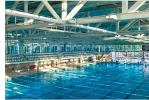
Eindrucksvolle Dimensionen: Die Basis des Gebäudes besteht aus einem geschosshohen Betonsockel, der von einer feinteiligen Stahlkonstruktion überspannt wird.
