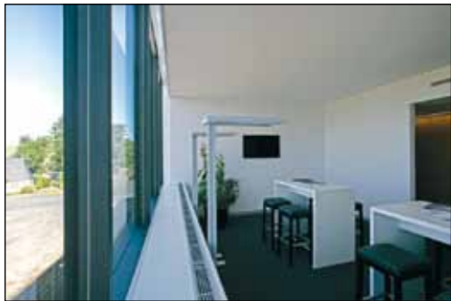
Oben und rechts der Schnitt durch das Gebäude und die Fassade Foto unten: Die hohen Fensterfronten verlaufen im Obergeschoss an der Decke vorbei bis fast zum höchsten Punkt der Attika.
