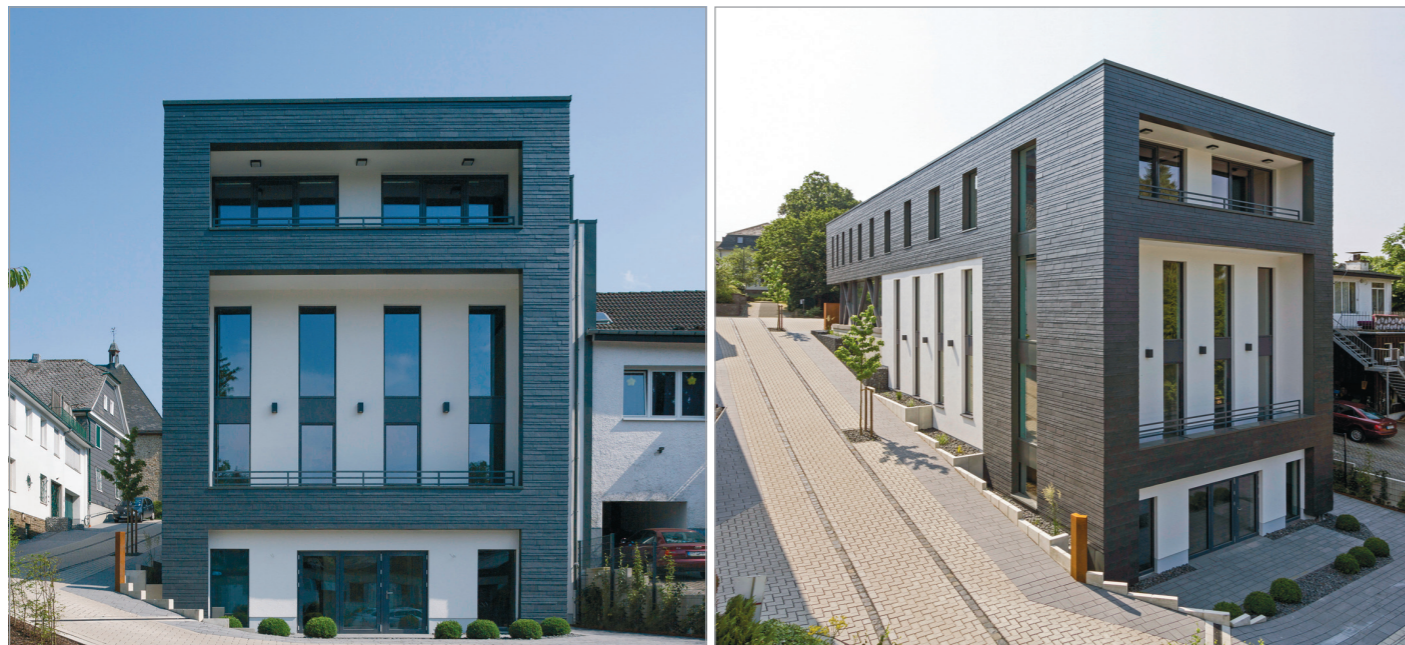
Die Fensterbreiten in der Längsseite der Fassade skalieren in der Breite von 0,6 bis 1,51 Metern. Von der Straße aus gesehen, wirken alle Fenster gleich breit und das Gebäude dadurch optisch verkürzt.
