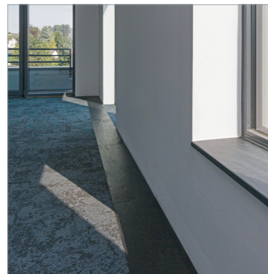
Eine hübsche Idee: Die Kabelkanäle in den Büros erhielten preiswerte Schieferwerksteine als Abdeckung, deren seidig glänzende Oberflächen ein attraktives Gestaltungsmerkmal sind. Auch die Fensterbänke wurden mit Schieferwerksteinen mit der gleichen Oberfläche ausgeführt (linkes Bild).
