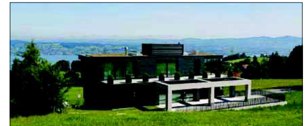
Die Gebäudeansicht von der Bergseite: Die Kühe grasen bis kurz vor der Terrasse.
