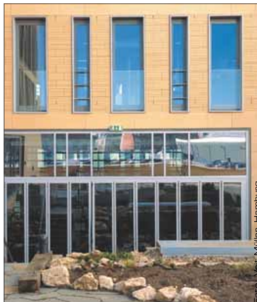
Gerillte Modul-Klinker markieren die Pfeiler zwischen den Fenstern; großformatige, glatte Steine, vorproduziert als Fertigteile, übernehmen die Verblendung und den Ausgleich der Geschosshöhen im Bereich der Geschossdecken.
