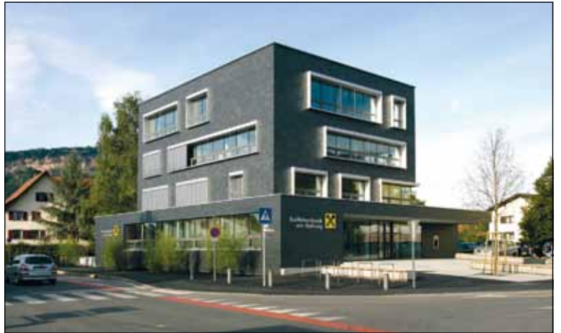
Raiffeisenbank in Wolfurt (Österreich) mit neuer Variante der dynamischen Schiefer-Deckung mit Aluminium-Faschen rund um die Fenster.
